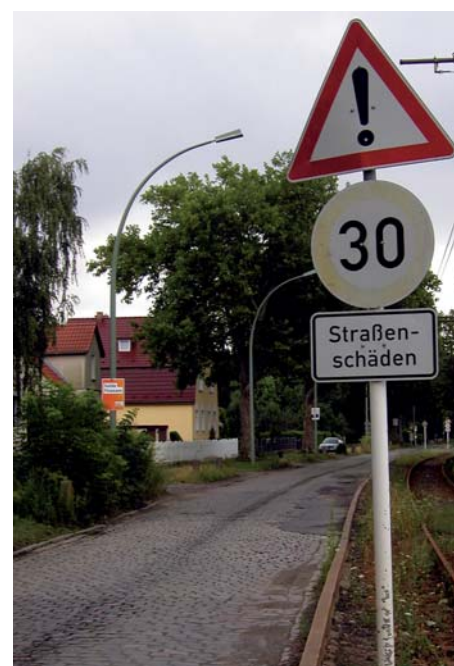
Baufällige Fahrbahn (in Rosenthal) Immer mehr Geld für immer schlechtere Straßen Foto: Bele Ducke
