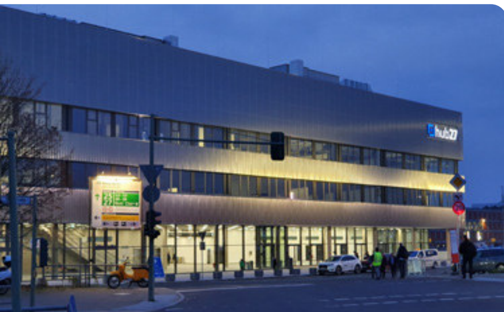
Multifunktional: die neue Halle 27, genannt „Hub 27“. Sie dient vorerst als Ausweichraum, während die ältesten Messehallen rund um den Funkturm saniert werden.
