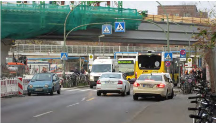
Nadelöhr Markgrafendamm – Hauptstraße: Baubeginn vor Kurzem, Fertigstellung voraussichtlich 2018 (Foto: Jan Müller)
