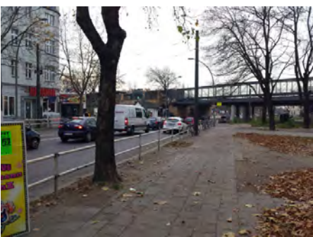
Nadelöhr Treskowallee: technisch aufwändige Lösung mit Gleisverschwenkung (Foto: Marc Würdemann)
