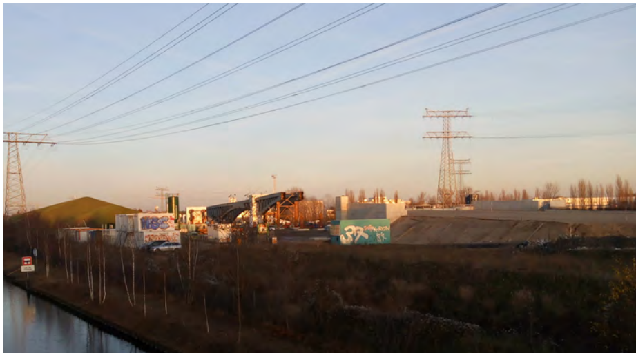
Süd-Ost-Verbindung im Bau: zunächst von der Rummelsburger Landstraße zur Köpenicker Landstraße, später vielleicht bis zur Neuen Späthstraße
