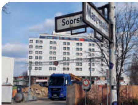
LKW statt Taxen: Taxihalte und altes Empfangsgebäude sind derzeit Baustelle.
